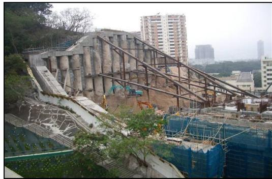
图 33-46 钻孔灌注桩前开挖
