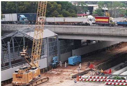
图 33-36 反压法贯入板桩
