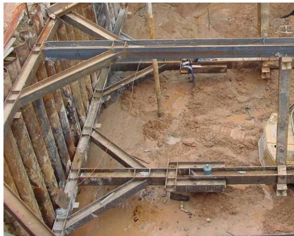
图33-28 围檩和支撑的连接详图33-
