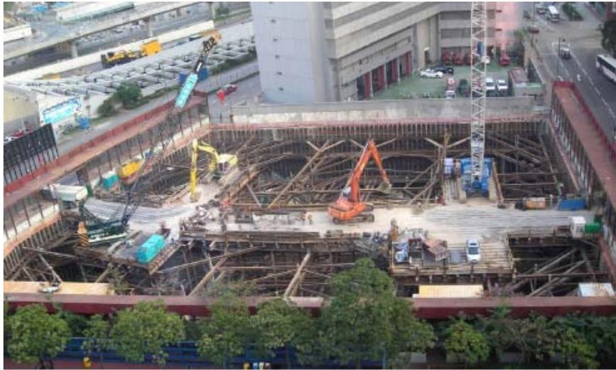
图33-38 基坑现场开挖图
