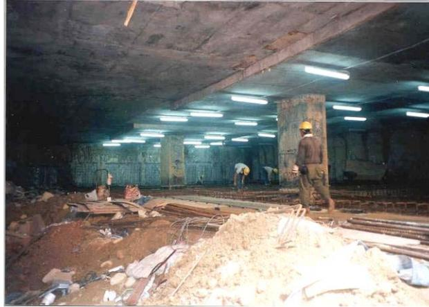
图 33-18 逆作法梁板结构
