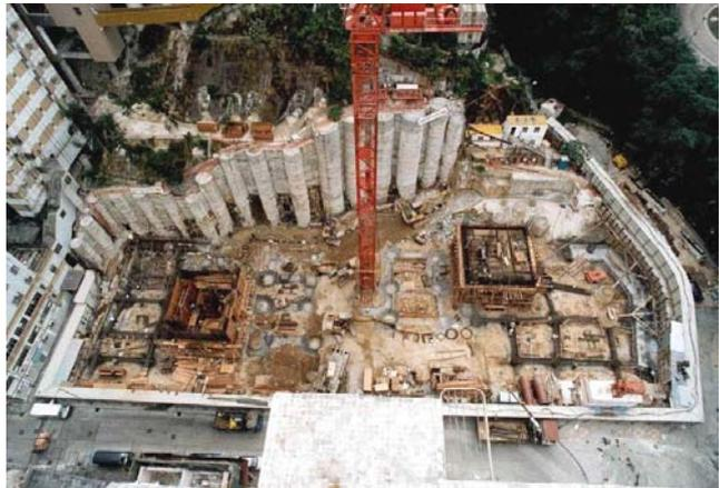
图 33-10 沉井和混凝土板条
