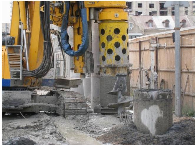
图 33-13 螺旋法施工灌注桩
