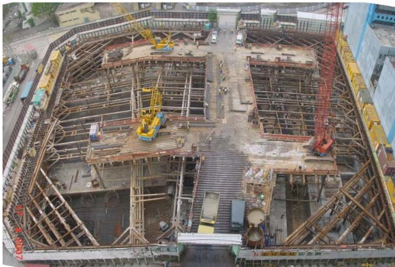
图 33-16 临时水平十字交叉钢结构支撑平台
