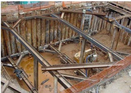
图 33-6 钢结构支撑钢管桩施工实例
