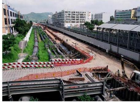
图 33-35 储水库附近的浅轨道基坑开挖
