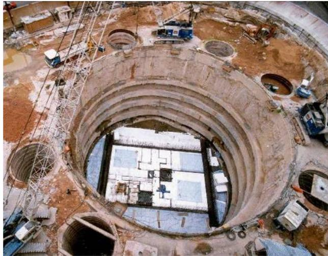
图 33-19 大直径圆形地下连续墙
