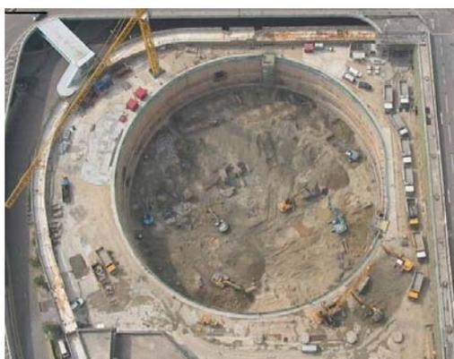
图 33-50 塔吊和起重机取土
