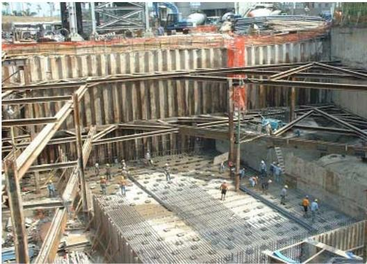
图 33-4 顺作法钢结构支撑板桩墙施工实例
