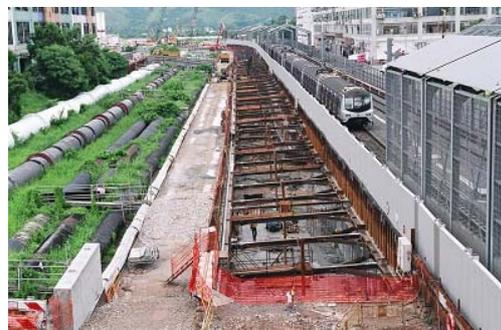
图 33-37 运行铁路旁隧道基坑开挖
