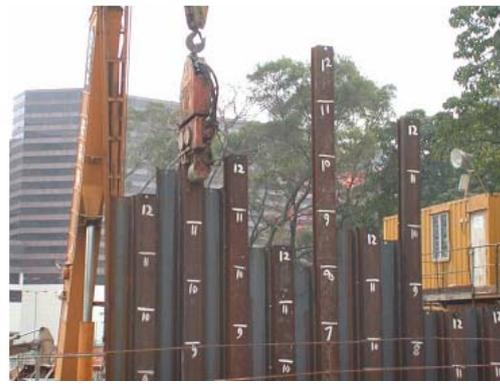
图 33-5 振动法贯入钢结构板桩墙
