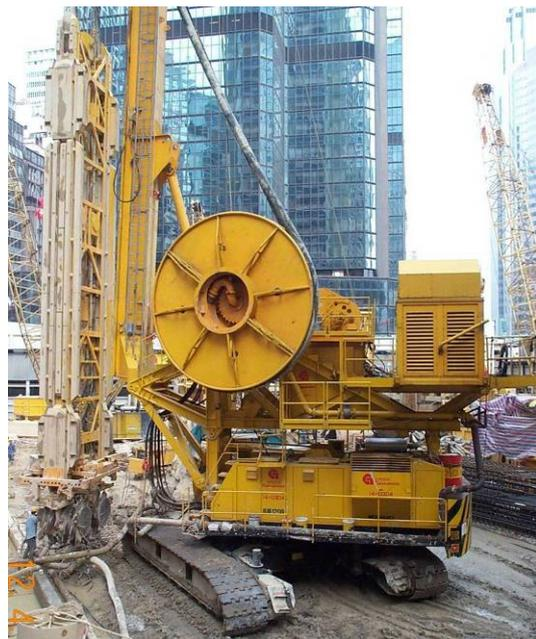
图 33-15 渠刀开挖连续墙槽段
