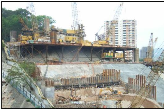
图 33-45 钻孔灌注桩施工
