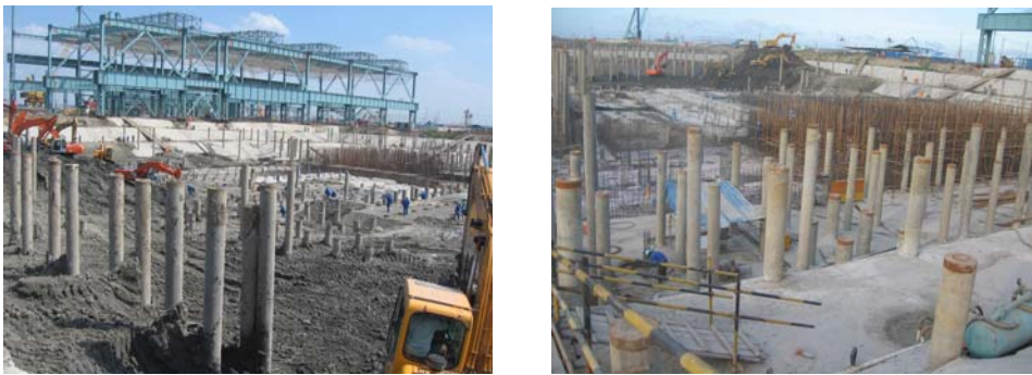
图 24-12 加热炉基坑土方放坡开挖图
