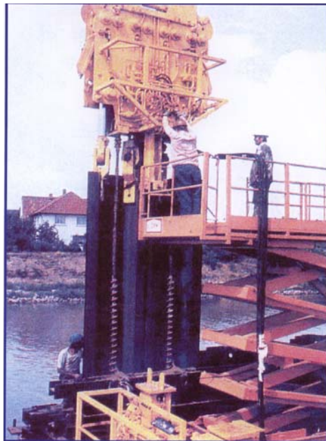
图 14-13 第二种压桩机械工作步骤
