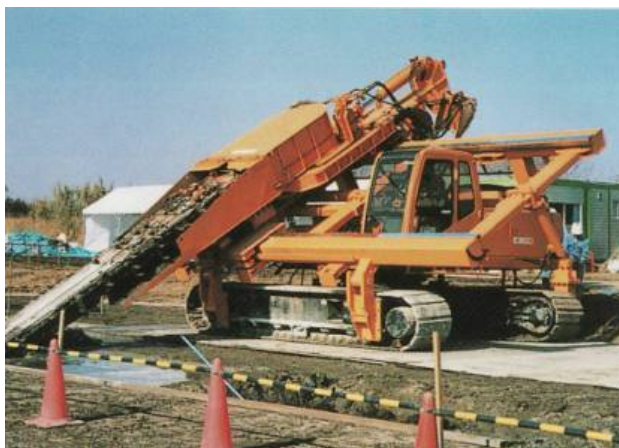
图 13-28 机架变角度水泥土搅拌墙施工
