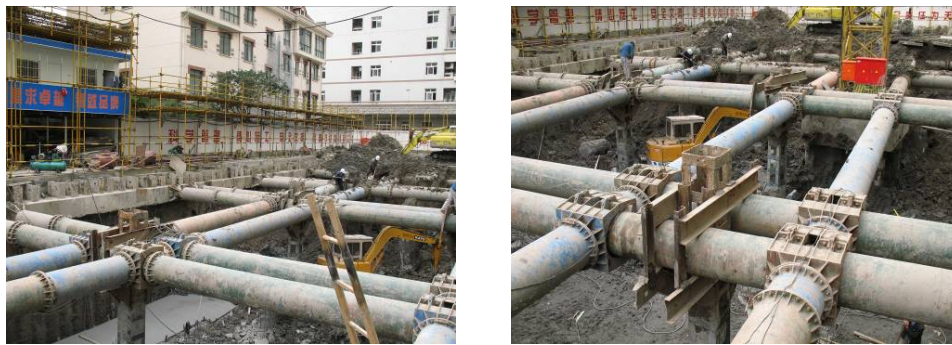
图 13-33 现场内支撑布置图
