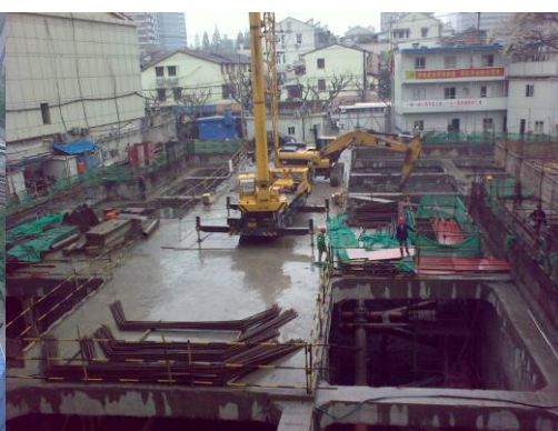
图 2.5-10 华山医院钢与混凝土组合支撑实景
