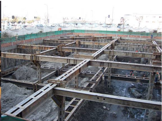
图 2.5-2 黄金置地车库十字正交型钢对撑
