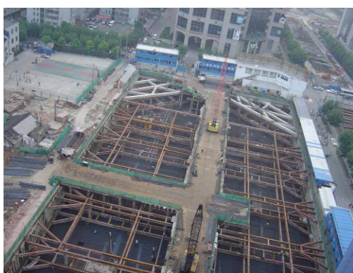
图 2.5-9 陆海空大厦钢与混凝土组合支撑实景
