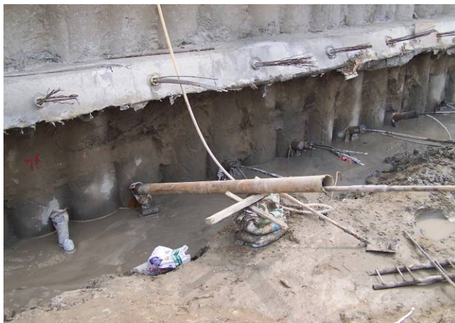
图 2.5-15 全套管跟进锚杆实景
