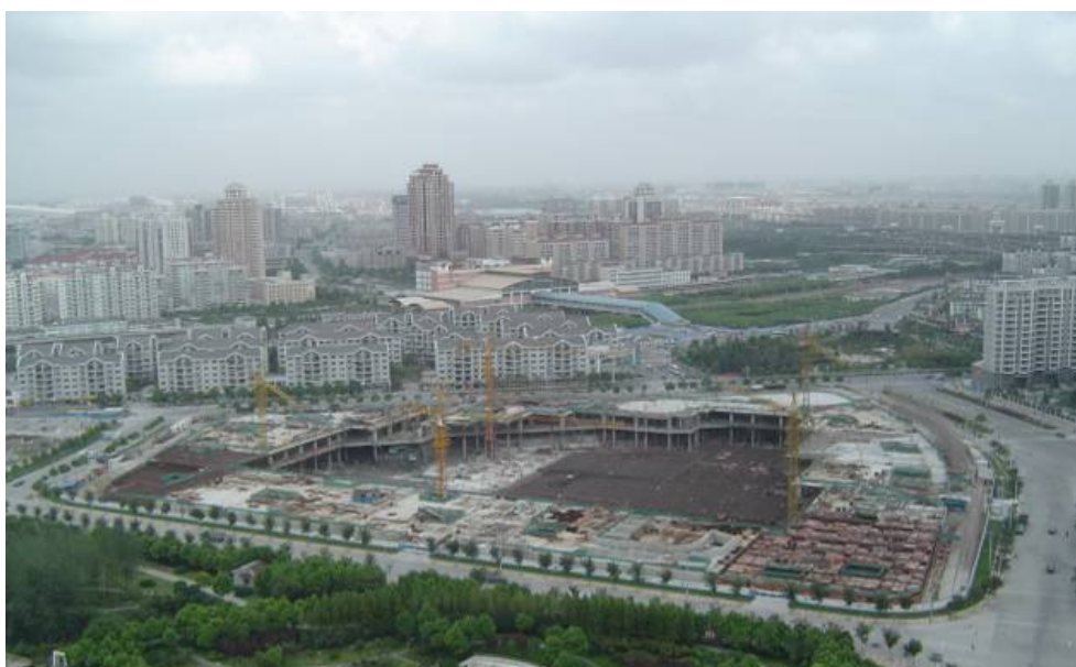
图 2-16 仲盛商贸中心基坑工程现场实景
